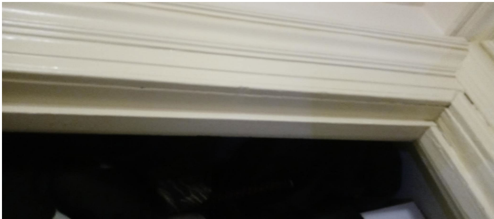
Bedroom 1 Closet Door Head Jamb
