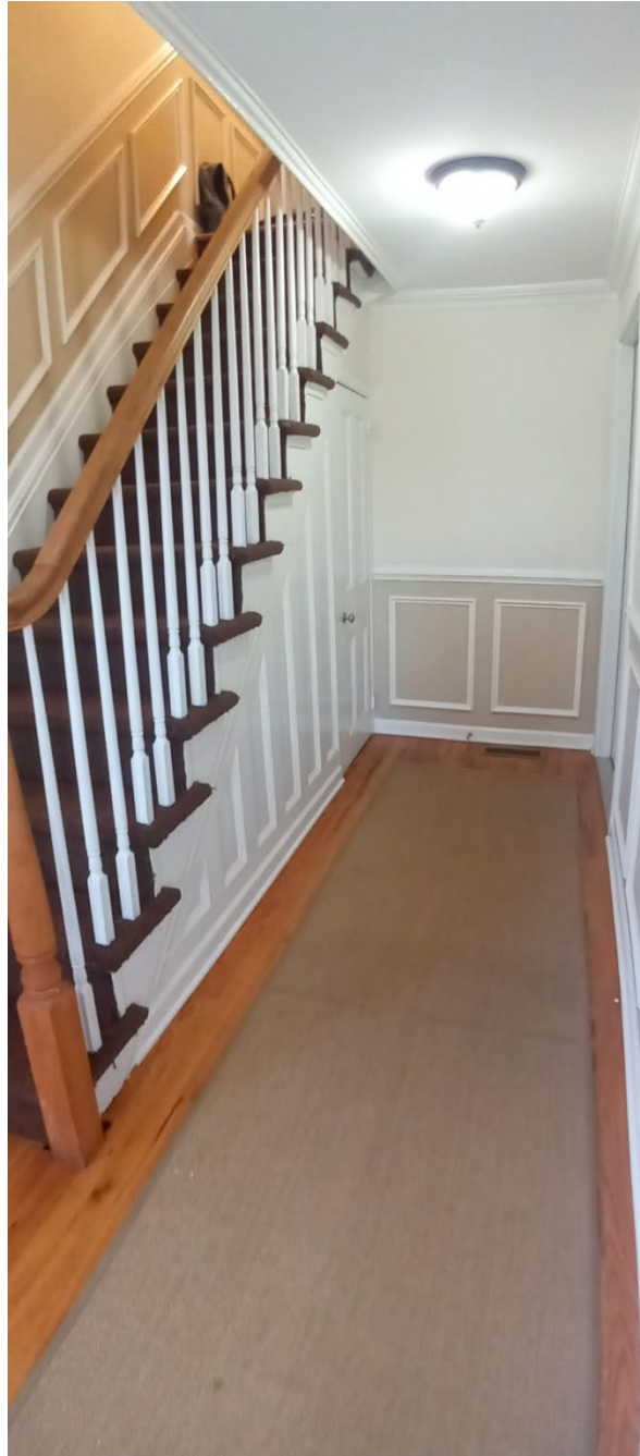
Stairwell: Stair & Door in Wall B2
